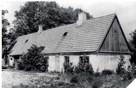
"Den gamle skole", lige før nedrivning, Foto ca. 1960.
